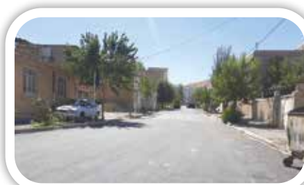
اتمام عملیات آسفالت خیابان شمس تبریزی (شهرک جهاد)
