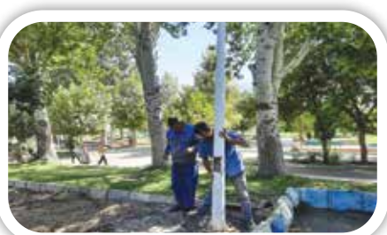
اتمام عملیات نصب پایه های روشنایی در پارک حرم
